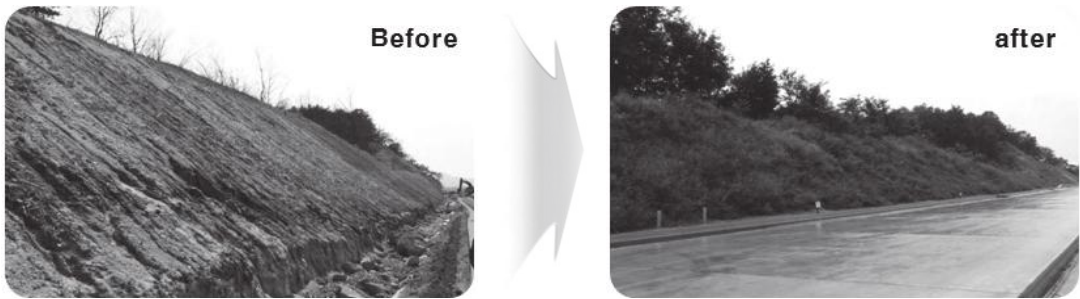
〈화강풍화토 비탈면에 본 기술을 적용한 현장 전경(담양~성산간 고속도로)〉
