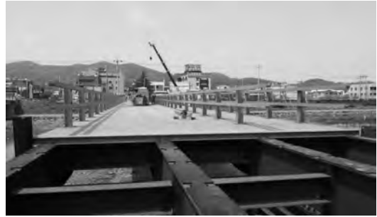
4. 복공판 설치(횡방향 일체형, 충격 흡수판)
