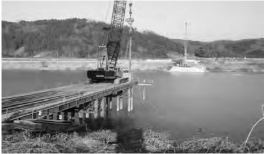
1. Pile 항타 (15m 추진식가능)
