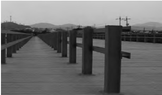
5. 난간 설치(복공판 강결설치)
