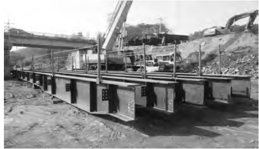
2. G.T.B Girder 조립(육상 가조립)
