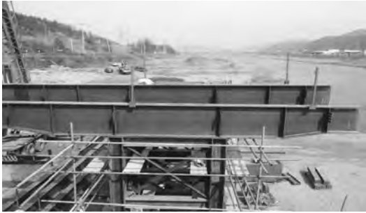
3. G.T.B Girder 거치(강결부 연결)
