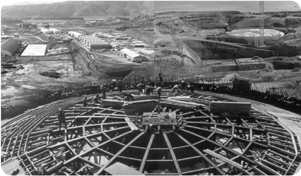
월성 1호기 건설 장면
