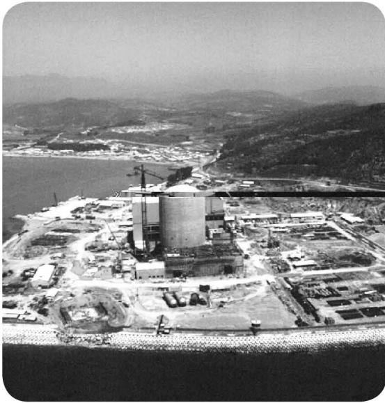
고리 1호기 건설 공사(1974)
