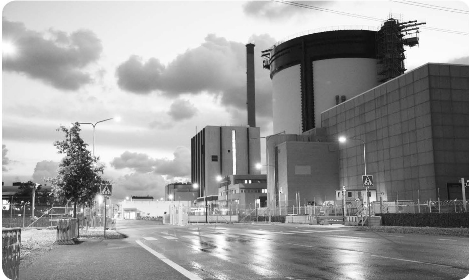
스웨덴의 Ringhals 원전. 스웨덴의 원전 조기 폐쇄는 쉽지 않을 전망이다. 집권여당연합인 사회민주당과 녹색당은 6월 10일 기존 원자로의 조기 폐쇄를 방지하기 위하여 향후 2년에 걸쳐 원자력에 부과하던 세금을 폐지하기로 합의하였으며, 사업자가 노후 원전을 대체할 원전 10기까지를 기존부지에 건설할 수 있도록 승인키로 하였다.
