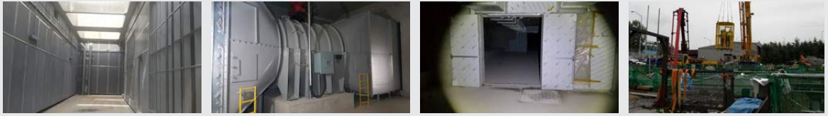
수직구#2(노반 수직구 환기실 및 기계공사 진행과정)
