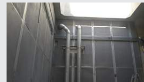
주박기지 (환기실 및 송풍기, 방음시설, 배수배관 설치 작업 진행과정)
