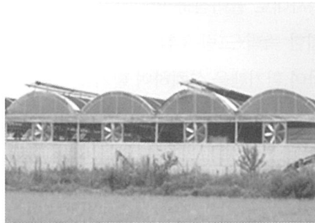
〈그림 4〉 환기팬 설치 방법
