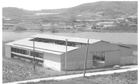
<그림 3> 양호한 상태의 지붕개폐식 우사 지붕
