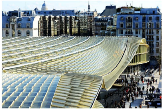
캐노피 전면부 _ 사진 Pierre Even
