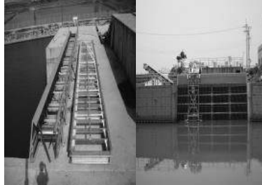
제진기 설치 공사 후 설치완료
