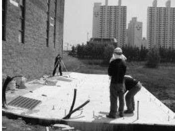
제진기 설치 전 고정 앙카작업
