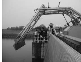
설치완료 후 시운전
