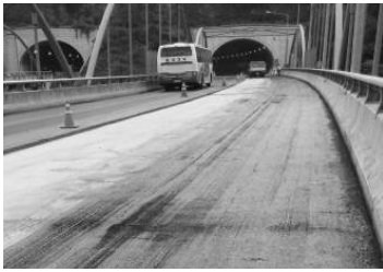
1. 시공전-절삭후 바탕면 청소 (물, 공기압축기)
