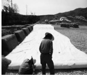
2. 앵커판 및 부직포 설치
