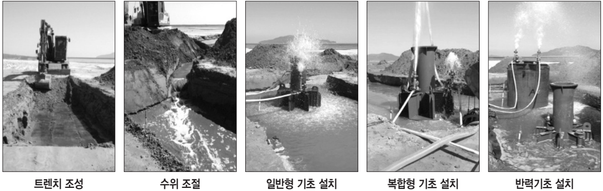
그림 3. 실험부지 조성 및 석션기초 설치
