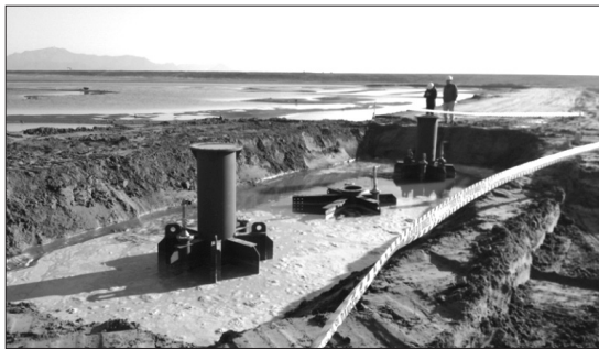
그림 4. 석션기초 설치 완료 모습
