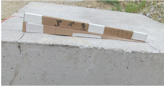
(a) 성형폭약 설치
