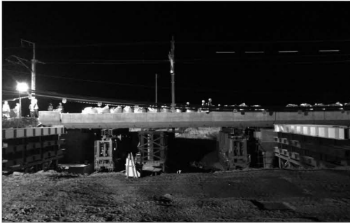
[그림 9] Smart Transporter 상부가설
