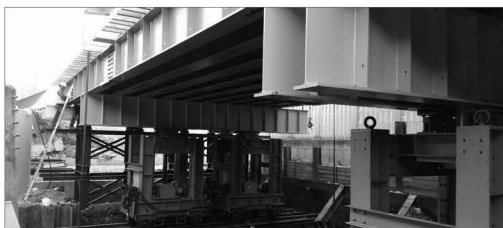
[그림 1] Smart Transporter 공법
