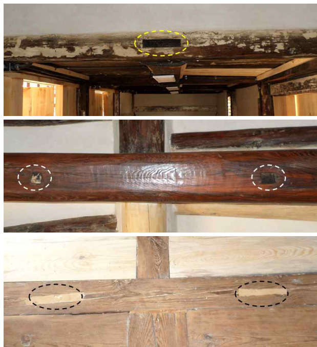
그림 5. 금역당 안채 동F 칸의 다락 장선 흔적(상) 및 동C와 동D 사이의 칸 구획 흔적(중·하)
