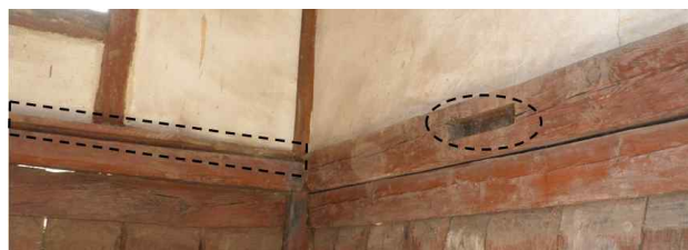
그림 6. 금역당 안채 서D 칸의 다락장선 및 청판 설치 흔적
