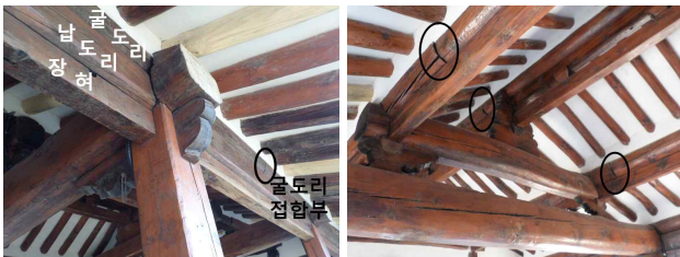
그림 8. 평주와 대공 상부의 결구(좌) 및 굴도리 접합부(우)
