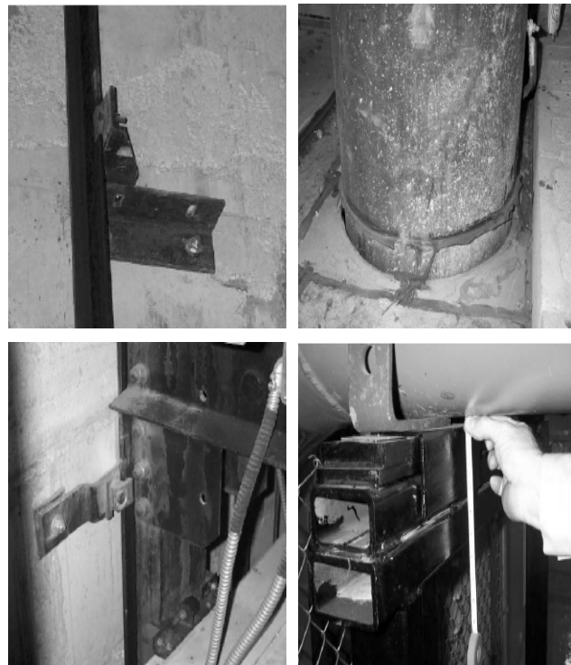
그림 1 부등축소에 의한 피해 개념 및 사례 2)
