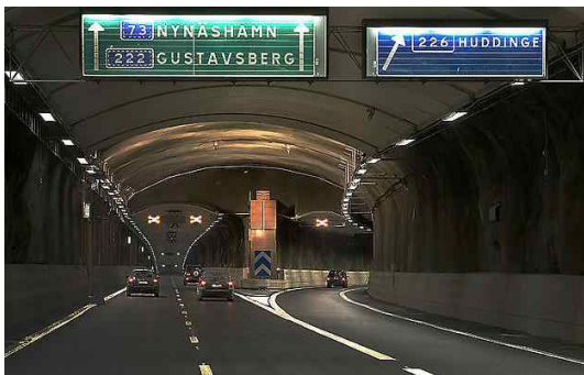
그림 8. 스웨덴 지하도로 (스웨덴 Södra Länken)
