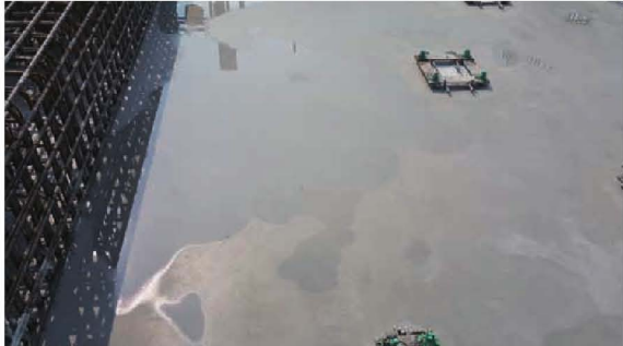
사진 2. 실시간 수화열을 이용해 양생관리한 구조물 표면
