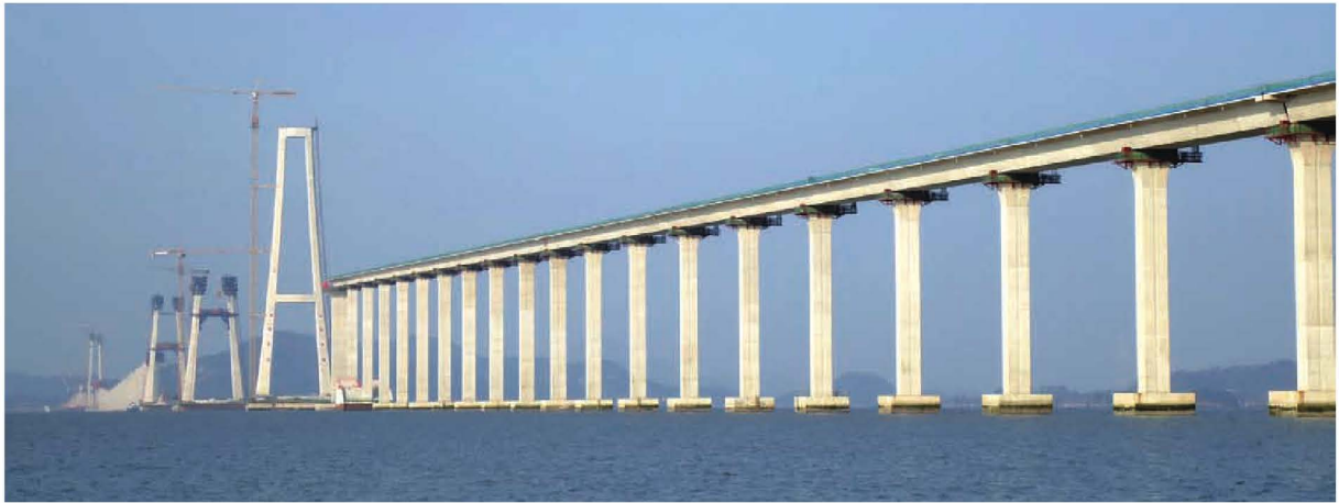
그림 2. 압해-암태(2공구) 도로건설공사 전경
