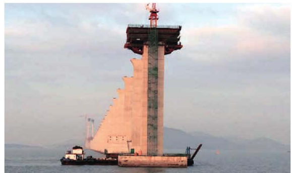
그림 6. 시점부 부탑 시공
