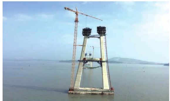
그림 5. 주탑(PY1) 시공(ACS 공법)
