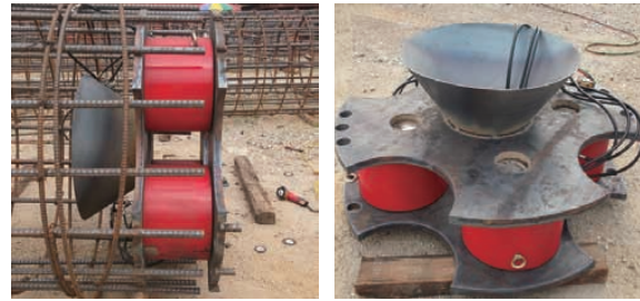
(a) 유압 Cell 설치 (b) 유압 Cell 그림 5. 재하시험 장치
