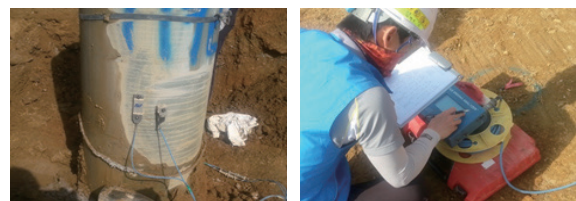
(e) 측정 게이지 설치
