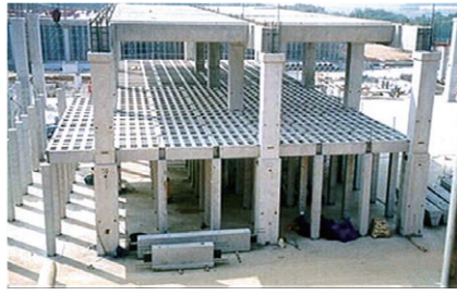
(b) PC 공법이 적용된 반도체 공장 시공
