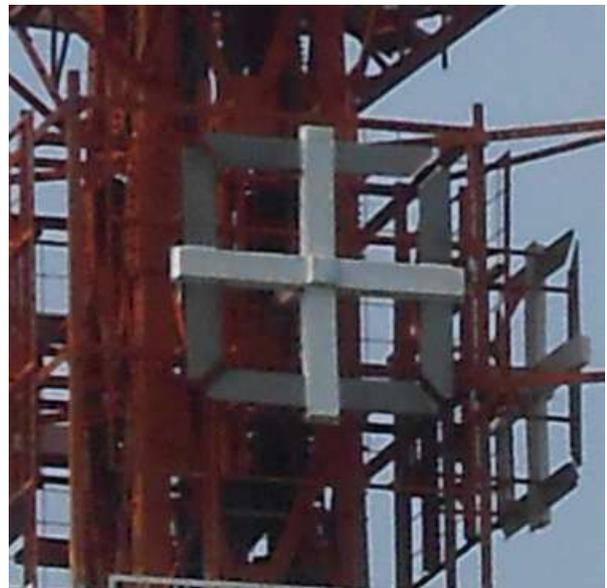
그림 1. CP-dipole 안테나
