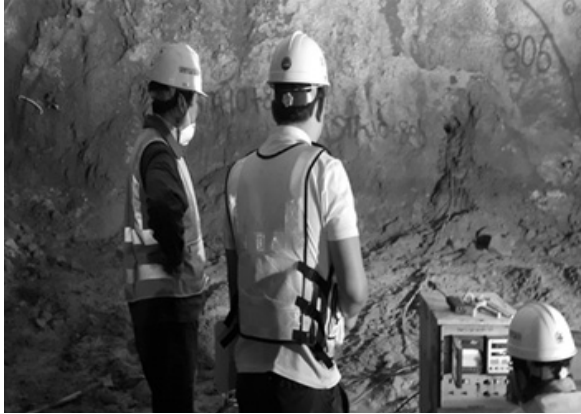
〈그림 9〉 시공 중 수압시험 전경
