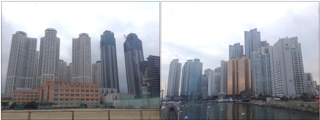
그림 1. 센텀시티 주상복합아파트 및 센텀중학교(좌), 마린시티 주상복합아파트(우)
