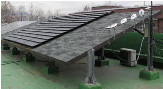
그림 1 태양광발전시스템 및 모니터링 시스템 구성 현황 Fig. 1 PV system and monitoring system configurations
