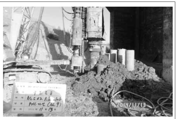
그림 6.2 Pile Slab 기초 PHC말뚝 천공 작업시 점토층 확인
