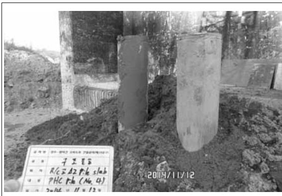
그림 6.2 Pile Slab 기초 PHC말뚝 천공 작업시 점토층 확인
