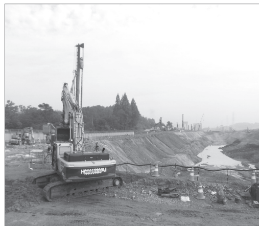
[사진 3] 동탄정거장 초기 공사 전경
