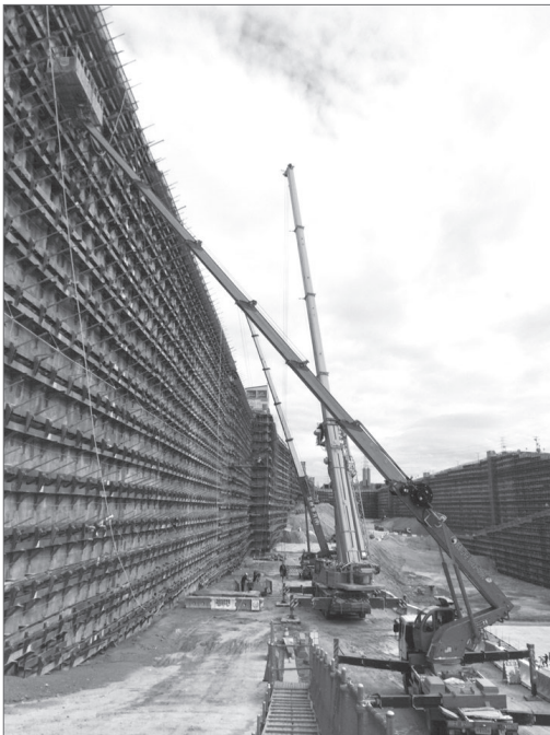
[사진 10] 앵커 보수/보강 전경
