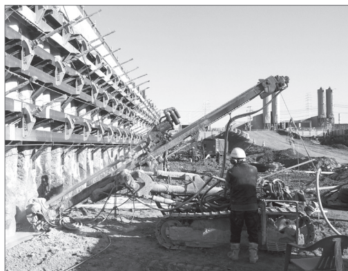
[사진 2] 그라운드 앵커 시공 전경
