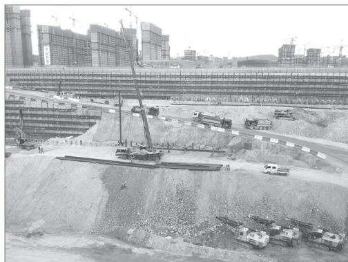
[사진 1] 엄지말뚝 시공 전경
