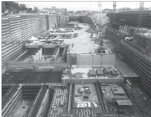
[사진 4] 동탄정거장 현재 공사 전경
