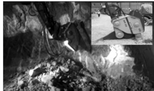
[그림 4] 진동리퍼를 이용한 기계굴착
