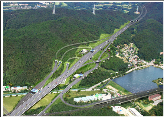
동탄 IC • IC형식 : 변형클로버 • 접속도로 : 국지도84호선 • 주요 구조물 - 교량 : 5개소 / 290m - 터널 : 3개소 / 930m
