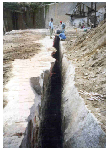
그림 6. Air-decking 효과를 이용한 장약 설계 사례.
