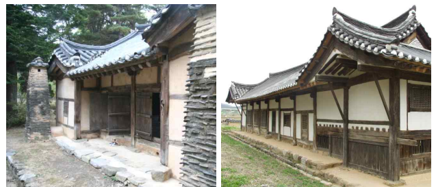
Fig.15 맹씨행단과 상주 양진당의 배면 지붕 구조
