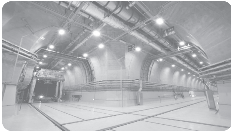
방폐장 지하처분장 하역동굴. 철저한 심사를 거쳐 2014년 규제기관으로부터 운영 허가를 받은 경주 방폐장은 동굴 처분 방식이다. 이 시설은 변경된 기준을 적용하더라도 우리나라에서 발생하는 중준위 방폐물 이하의 폐기물을 처분할 수 있는 처분 시설이다.
