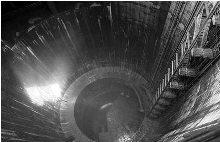
〈그림 8〉 수도권외곽방수로 입항(좌) 및 드롭샤프트(우하)
