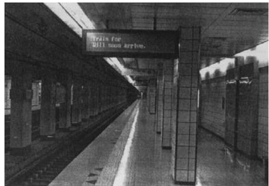
사진 2.4 중앙로 역 승강장 전경
