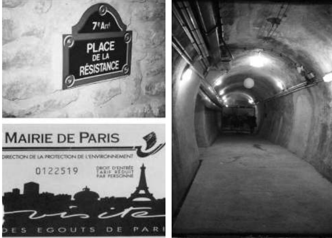
사진 2. 150여 년 전에 건설된 파리 하수도 • 기상이변에도 충분한 통수단면을 가짐 • 전력과 통신구로도 이용되고 있다.
