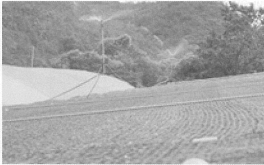
(지붕 스프링클러 설치)
