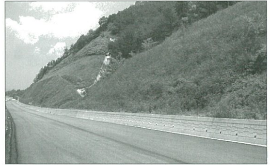
그림 7. 지표근입 지압판 시공 전경
