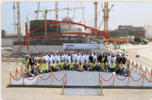
UAE 원전 4호기 최초 콘크리트 타설 기념행사
