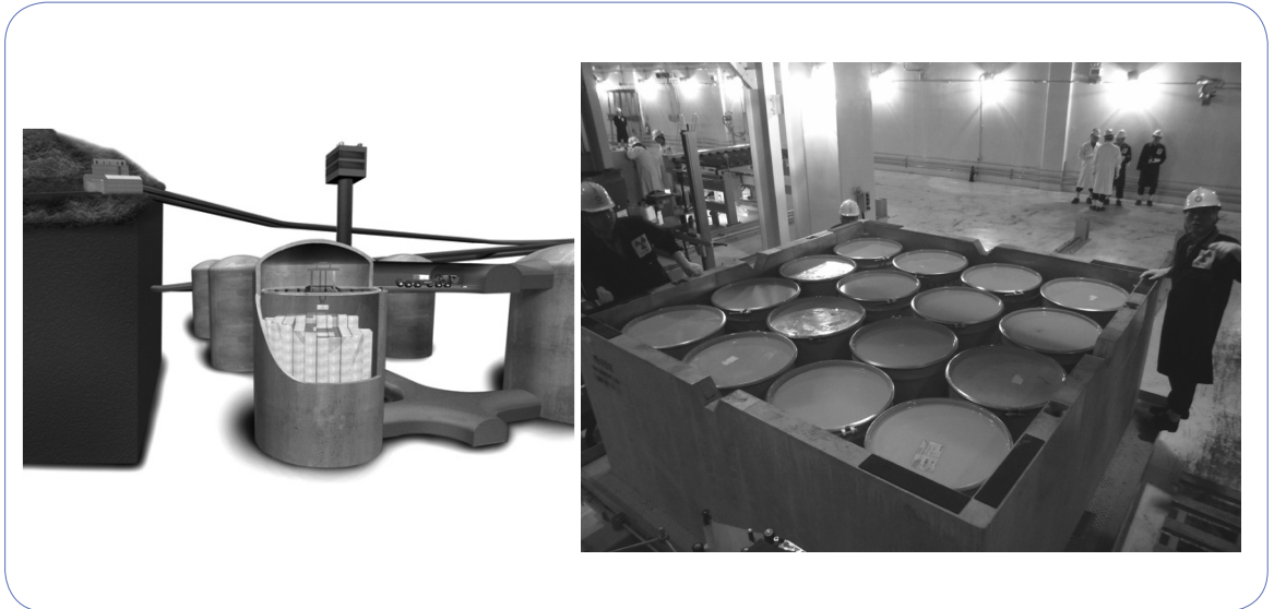
방폐물 처분 개념과 처분용기에 담긴 방폐물. 경주 방폐장은 약 210만㎡ 부지에 80만 드럼의 중·저준위 방폐물을 처분할 수 있는 규모다.
