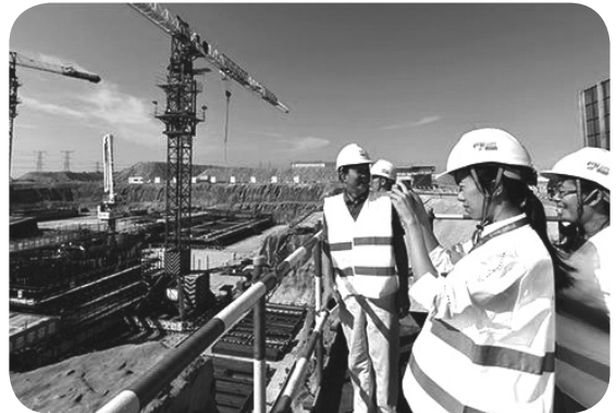
중국 푸젠 지방의 원전 건설 현장
