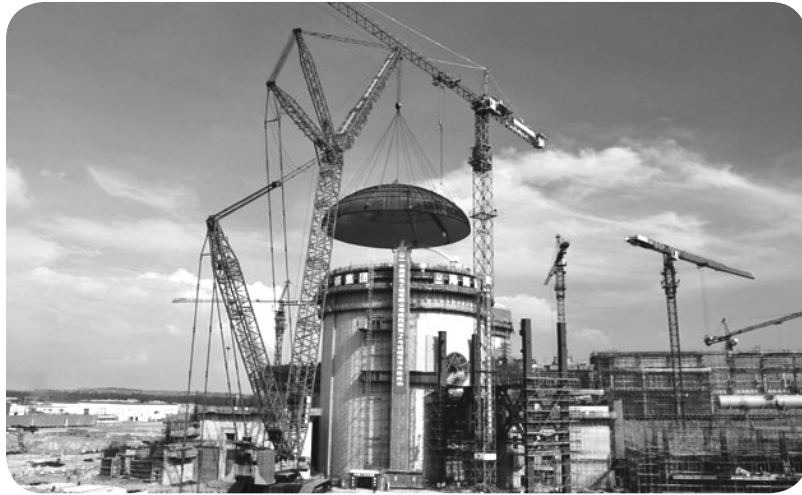
중국의 원전 건설 현장. 원전 프로젝트에서 나타나는 동아시아 국가들만의 중요한 공통적 특징은 유능한 정부의 기획 능력, 검증된 복합적 인프라 건설 수행 능력이다.
