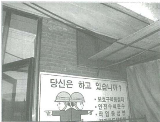
[세면장창문: 개방하기가 곤란함]
