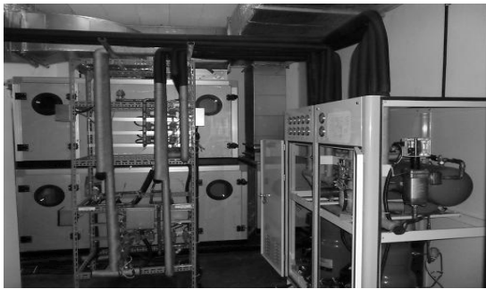
그림 5. 히트펌프를 이용한 배기열 회수 공조시스템
