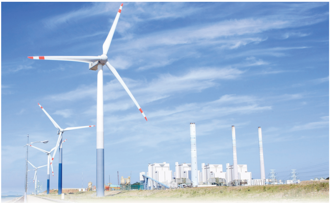
영흥화력발전소는 화력설비와 더불어 풍력, 태양광, 해양소수력 등 신재생에너지 설비가 조화를 이루는 친환경 에너지 복합발전단지로 발돋움 했다.
