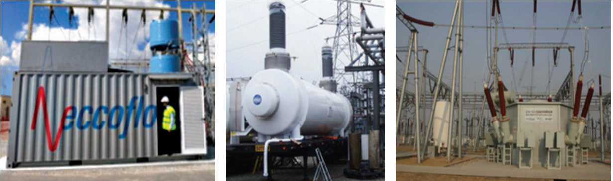
그림 6 Eccoflow 프로젝트의 24kV/1,000A급 초전도 한류기(좌), 미국의 115kV/900A급 단상 초전도 한류기(중), 중국의 220kV/800A급 초전도 한류기(우)
