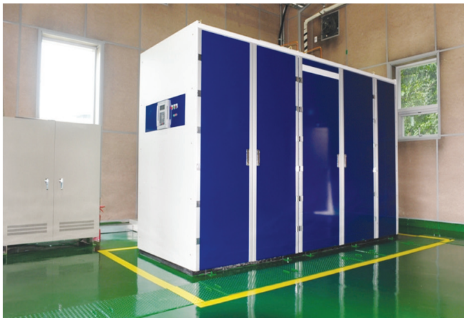
그림 5 이천변전소에서 운전되고 있는 22.9kV/630A급 초전도 한류기(좌) 및 초전도 한류기 설치 위치(우)
