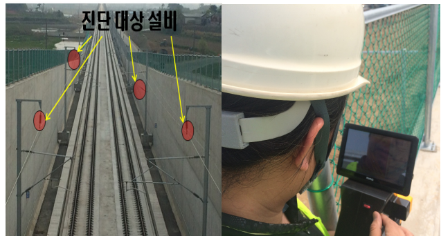
그림 4 호남고속선 정읍-익산간 Test-bed 현장 시험 사진
