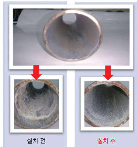
[그림 13] 다기능 수처리 장치 전 후 배관 스케일 방지 상태
