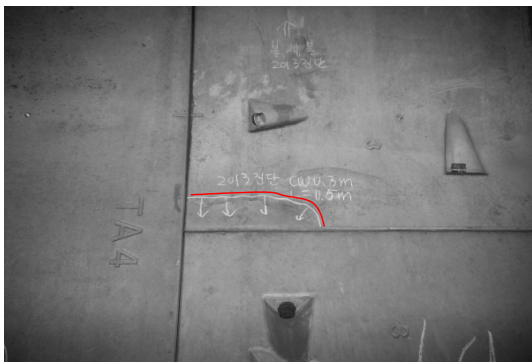
b. TBM 터널식전력구 결함: 좌-균열, 우-누수 및 균열
