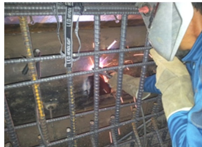
(d) Installation of sensor ④
