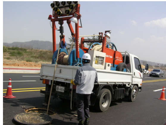
그림 7. 더블브레이드 로프가 권선된 디지털 풀러와 데이터 수집 장치가 적용된 기계식 포설 장비의 실제 모습 Fig. 7 The actual appearance of the wound double braided rope puller with digital data acquisition device is applied to the mechanical laying equipment
