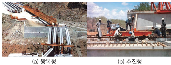
사진 2. 거더 공급 방식
